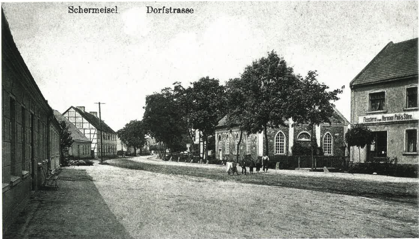
SYNAGOGA W TRZEMESZNE DIE SYNAGOGE IN SCHERMEISEL
